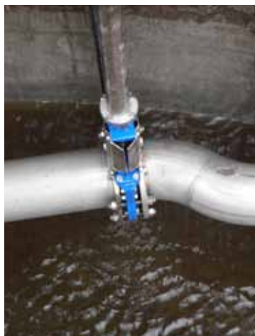
Станция очистки сточных вод Зееберген, Германия 3 VAG ZETA® Ножевые задвижки
