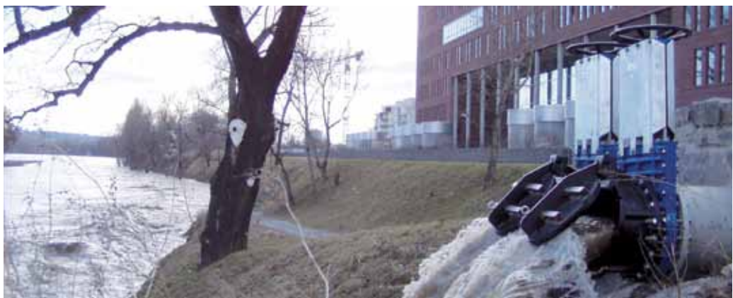
Защита от наводнений Прага, Чехия 2 VAG HADE® Обратных клапана и 2 VAG ZETA® Ножевые задвижки
